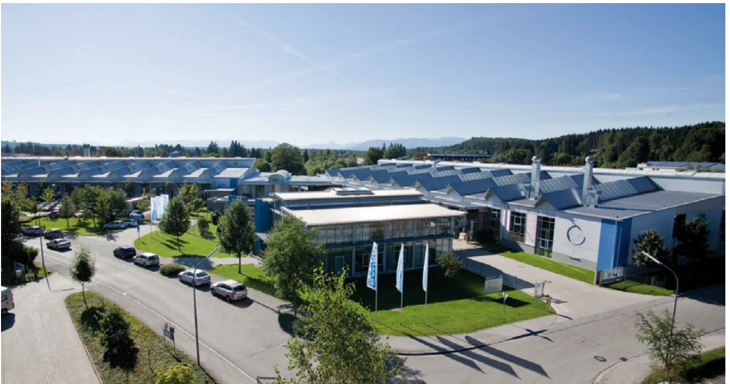
Usine I de BAUER KOMPRESSOREN – Geretsried, Allemagne
