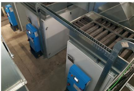
Hochdruckverdichter von BAUER versorgen die Pressen mit dem nötigen Druck.
