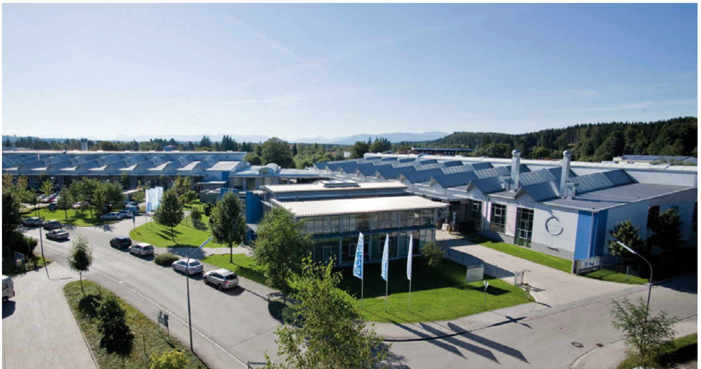
BAUER KOMPRESSOREN Werk I - Geretsried
